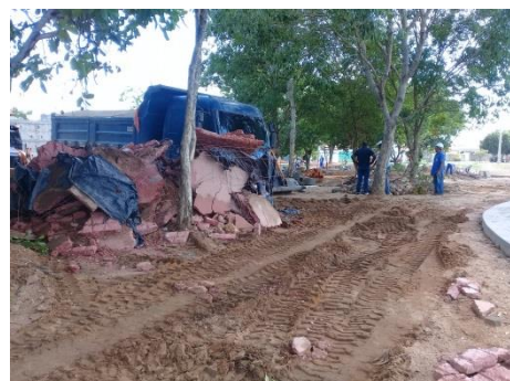
(b) Detalhe do bota fora da demolição do pavimento.
