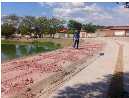
(a) Detalhe da demolição do pavimento.
