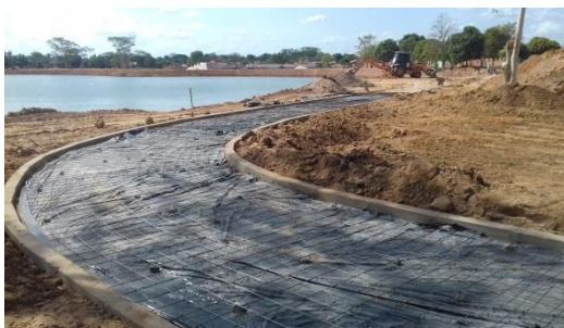
(a) Detalhe do filme plástico e da armadura da laje de concreto armado.
