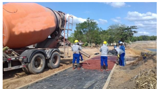
(b) Detalhe concretagem da laje de concreto armado.
