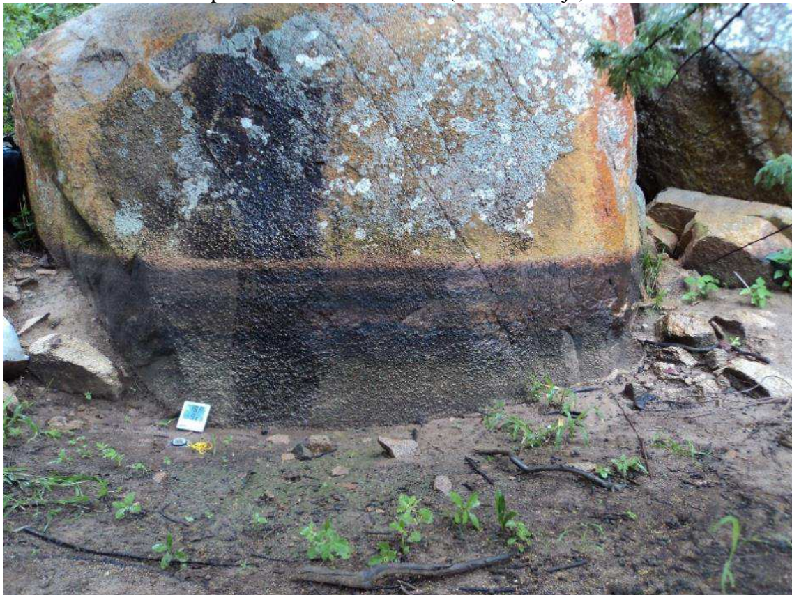
Figura 9 – Problema de conservação antrópico: área escavada na base do bloco granítico, à procura de ouro enterrado (mito da botija).
