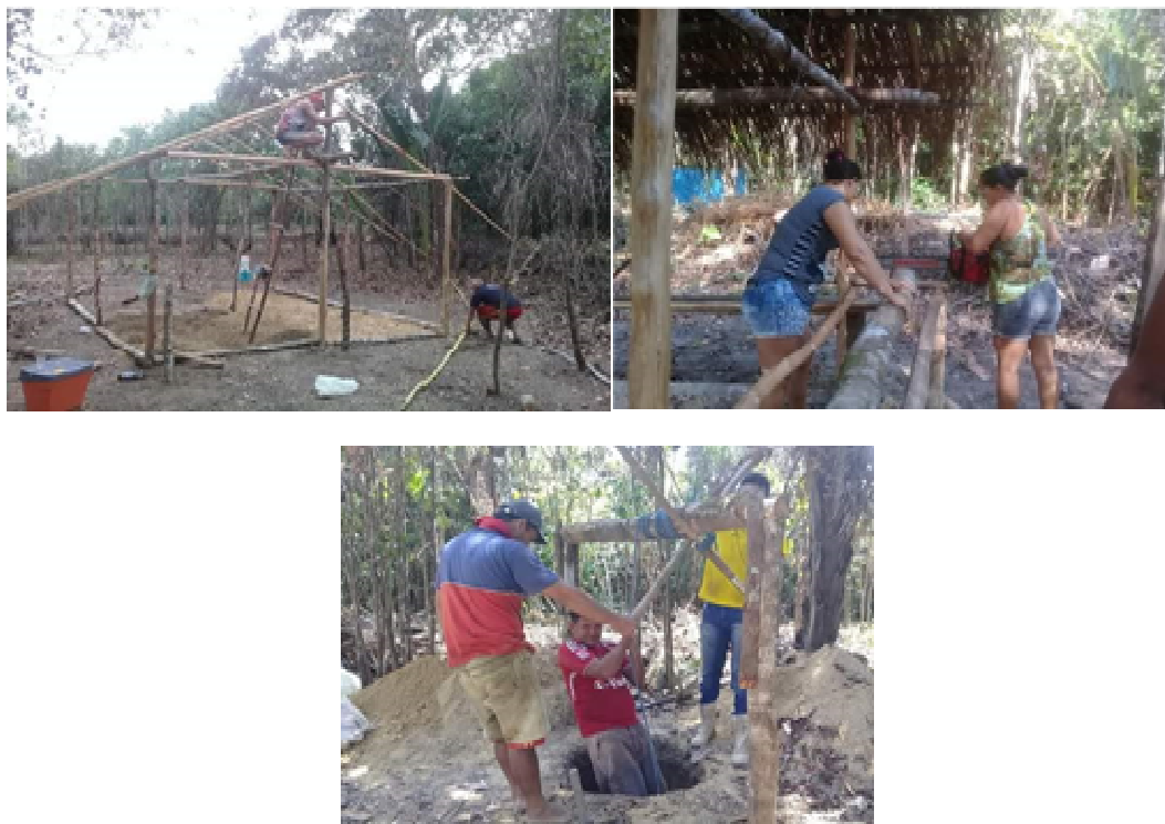
Fotos 1, 2 e 3: Mutirão de construção da sede da ASAPAP.
