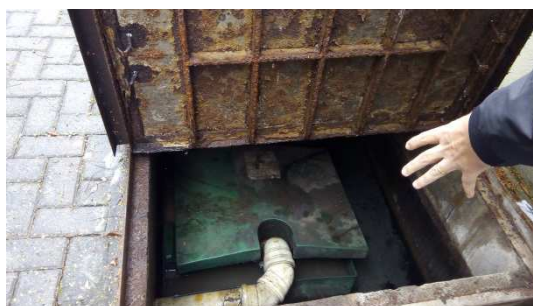
Figura 3 – Caixa de coleta com bomba submersa e separadores de água e óleo.
