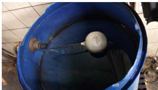
Figura 4 – Água limpa, não potável, após o tratamento.
