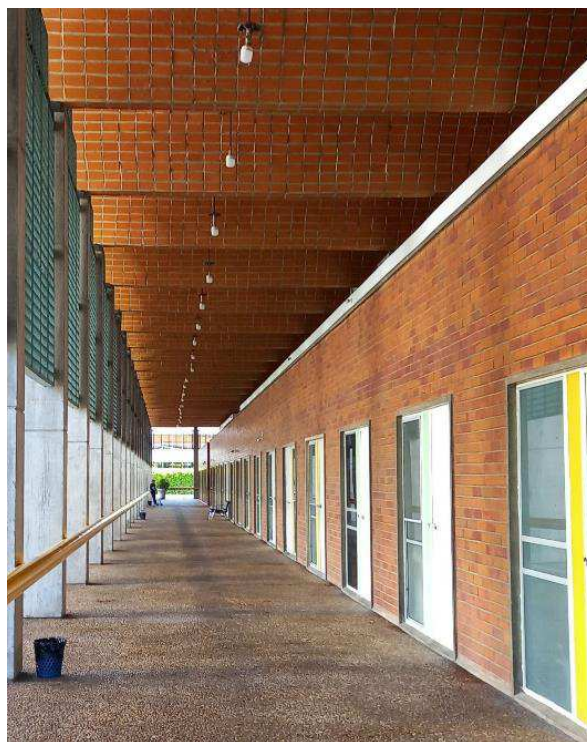
Figura 5 – Destaque da varanda da fachada
